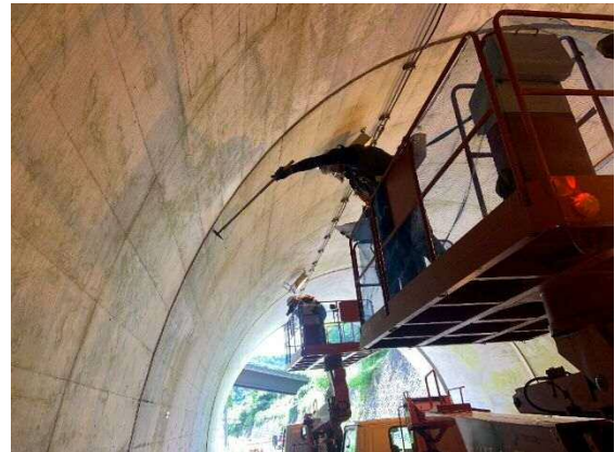
写真 3-2. 近接目視・打音検査
