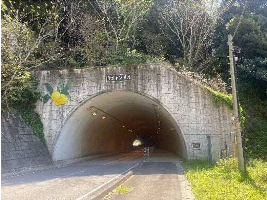
丹生トンネル
