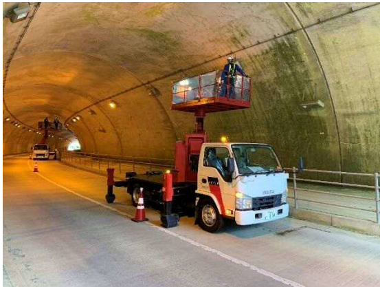
写真 3-1. トンネル点検車による点検状況
