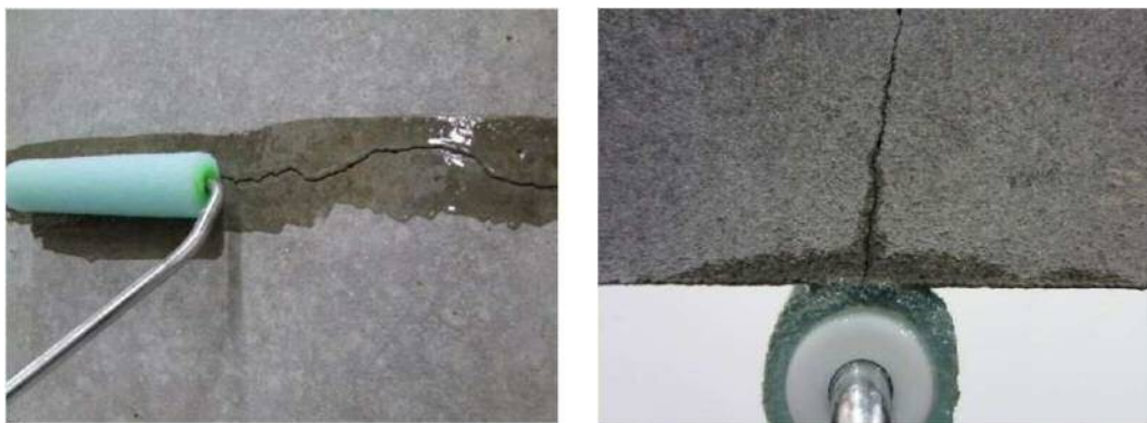
写真 6-1. ひび割れ塗布浸透接着工
