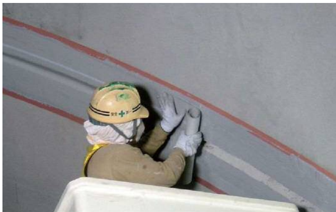
写真 6-2. TN セーフティーシート工
