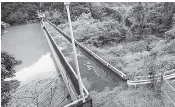
増間ダム堤頂部
