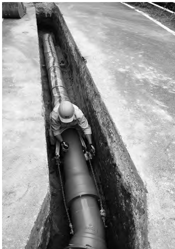
配水管敷設替工事
