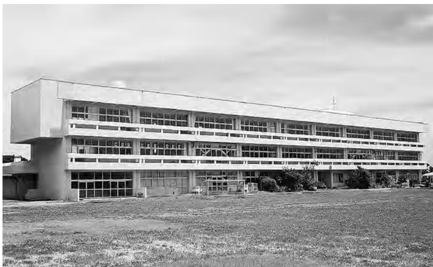
旧忽戸小学校舎
