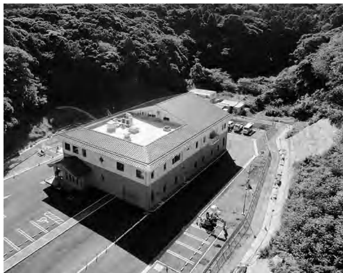
南房総市水処理センター
