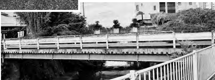
千倉橋西側の川尻橋
