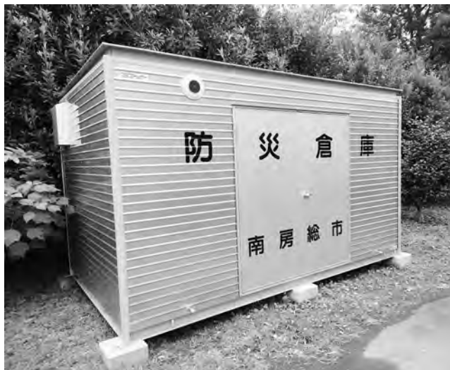
令和3年9月新設倉庫（富浦中）
