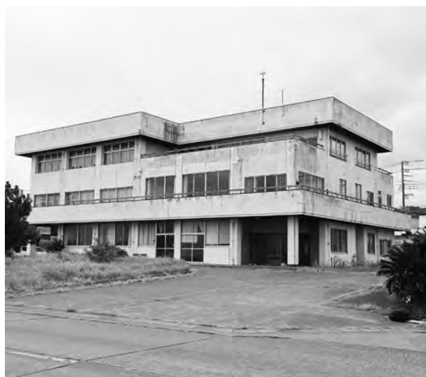
解体予定の千倉漁村センター
