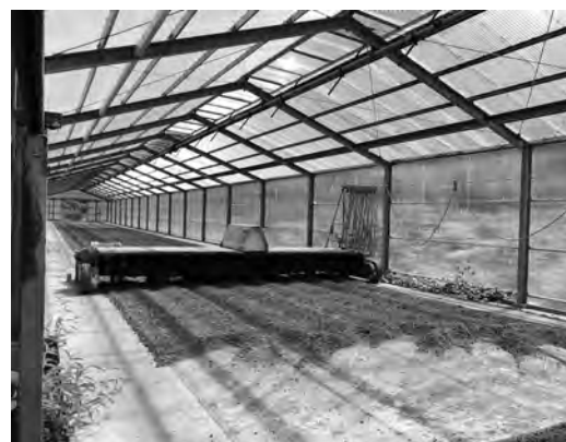
機械攪拌式堆肥製造施設
