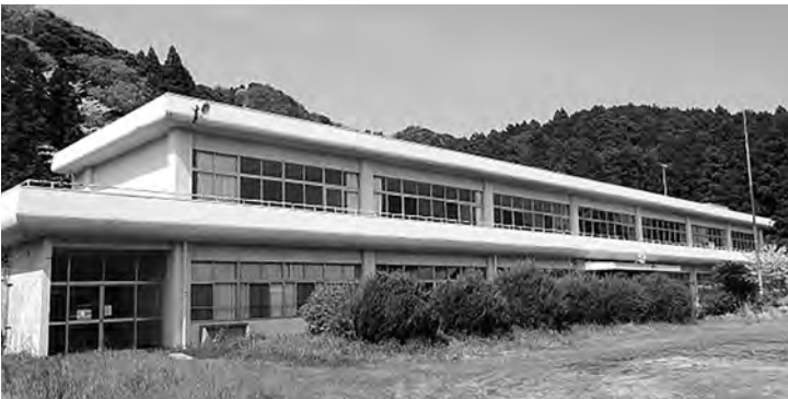
旧平群小学校跡地 現在の状況
