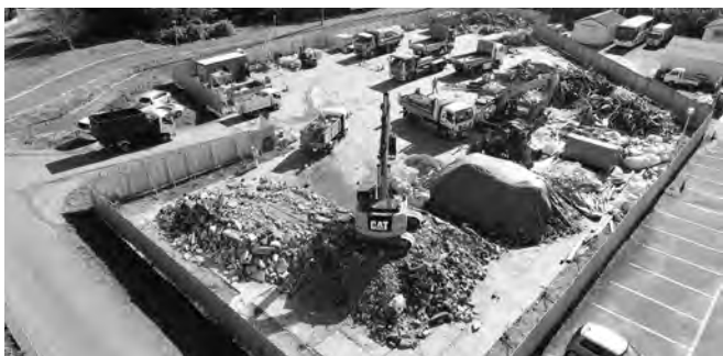
家屋解体廃棄物仮置き場
