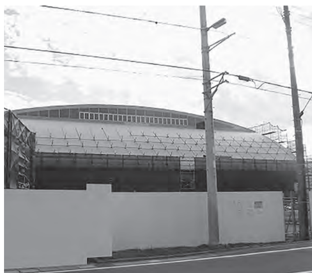
改修工事中の富山ふれあいスポーツセンター
