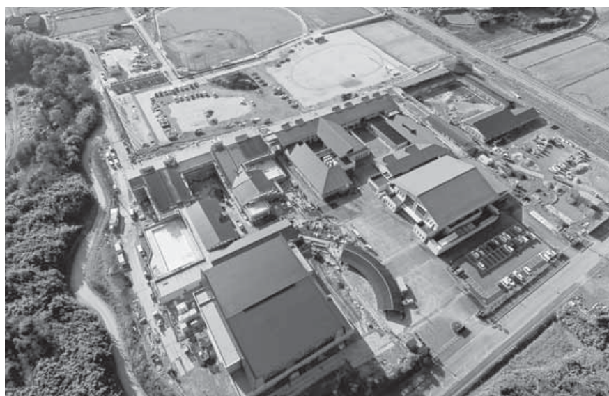
丸山・和田地区統合小学校建設現場
