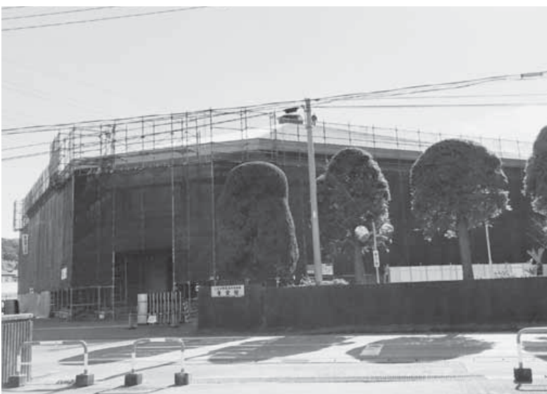
改修中の三芳中学校体育館
