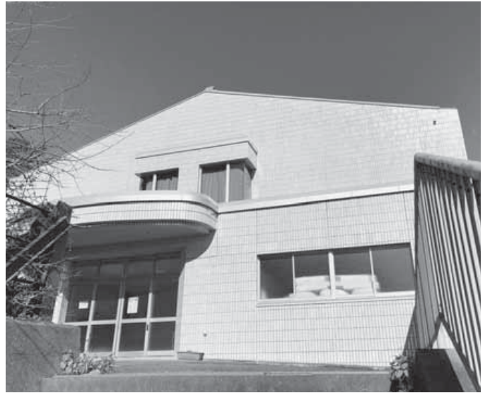
和田小学校体育館
