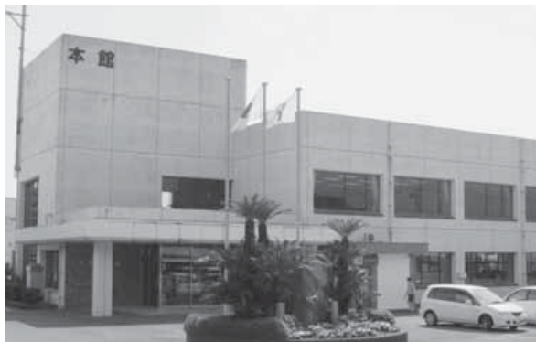
大規模改修を行う富浦本庁舎
