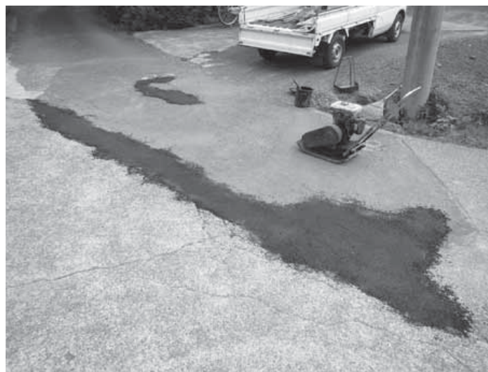
市道の修繕工事
