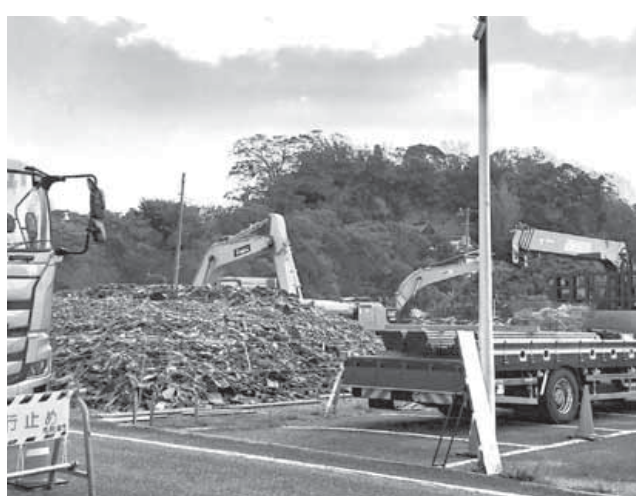
市役所本庁前の被災ごみ仮置き場
