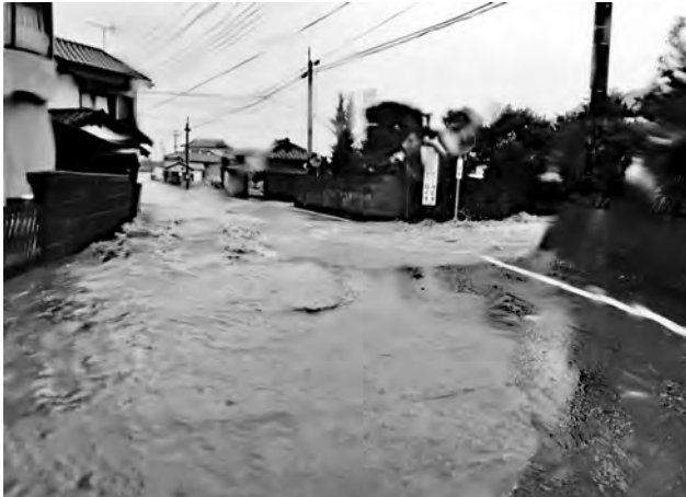
冠水した国道 410 号（千倉地区白間津）
