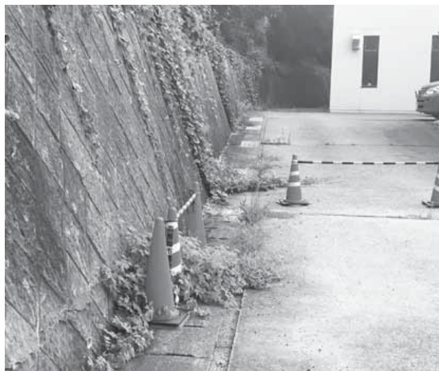
富山ふれあいコミュニティセンター裏手の壁に亀裂
