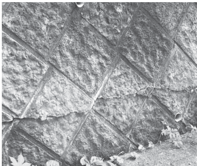
富山ふれあいコミュニティセンター裏手の壁に亀裂
