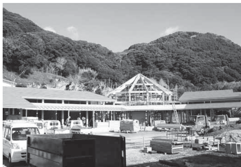
建設中の白浜こども園
