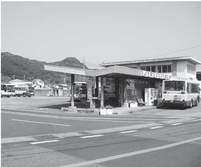
解体整備が進んでいるＪＲバス関東安房白浜駅
