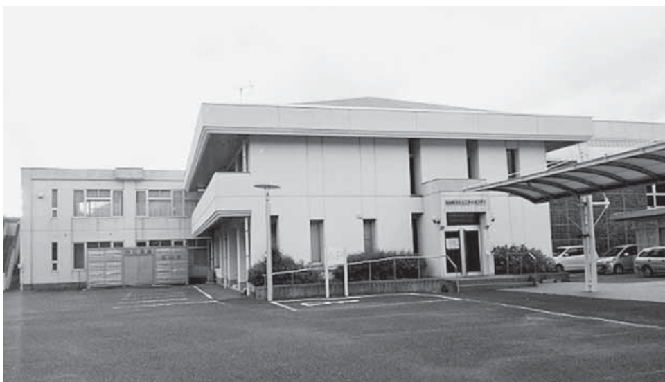
施設の老朽化に伴い用途廃止・解体される丸山コミュニティセンター
