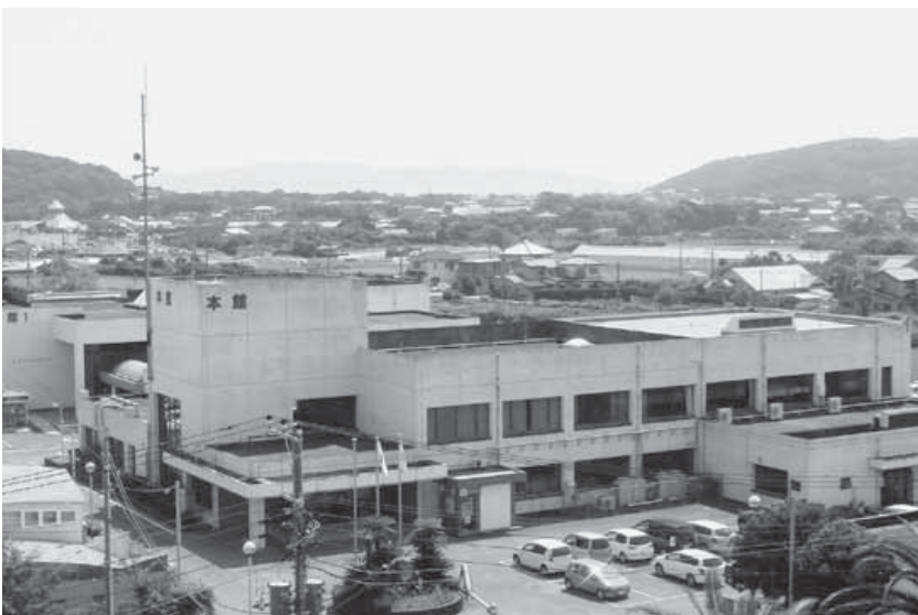
災害対策本部が設置される本庁舎を耐震診断（2次診断）
