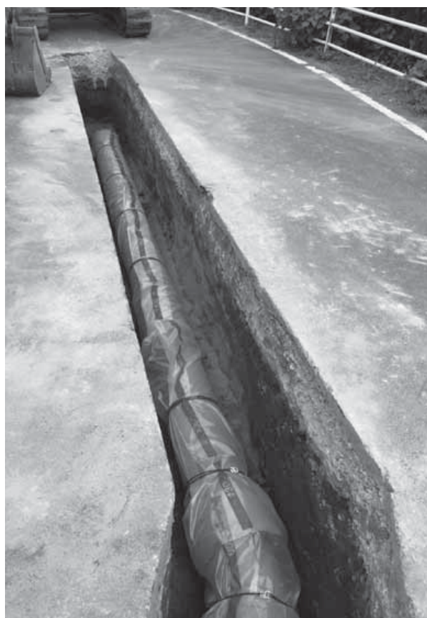
老朽管・石綿管の工事
