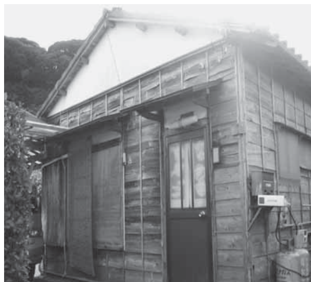
大房団地（富浦地区）
