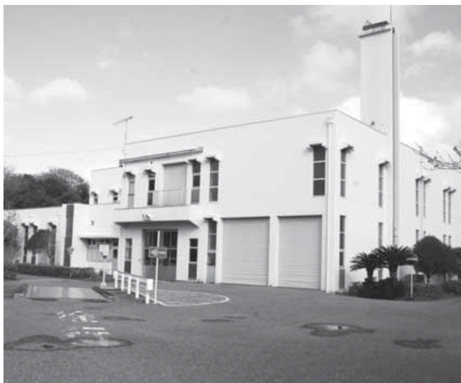
老朽化した千倉衛生センター
