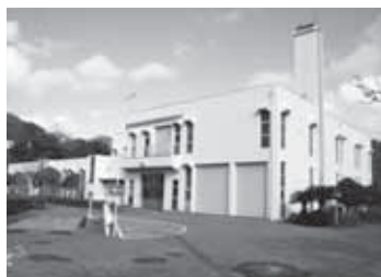
千倉衛生センター
