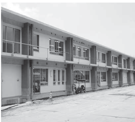
建設中の富山小・中一貫校
