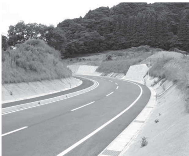
完成した川谷工区の国道 410 号
