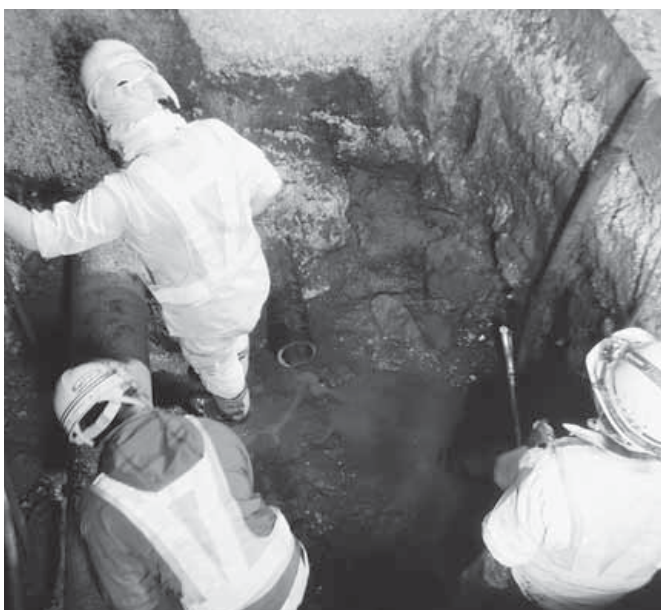
迅速な対応が求められる漏水工事
