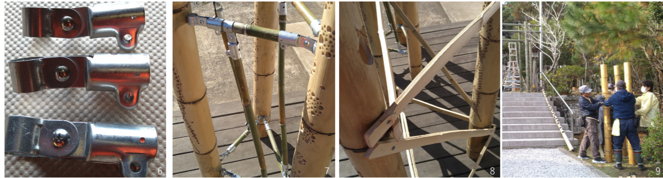
6 新固定システムで使用するビニールハウス用金具ユニバーサルジョイント 7 新固定システム 8 旧固定方法 9 旧固定法での竹灯籠の設置風景
