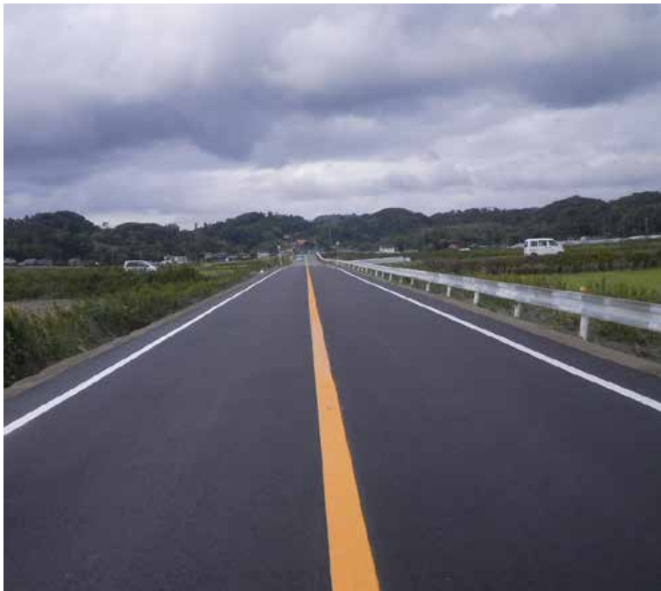
池之内9号線舗装修繕
