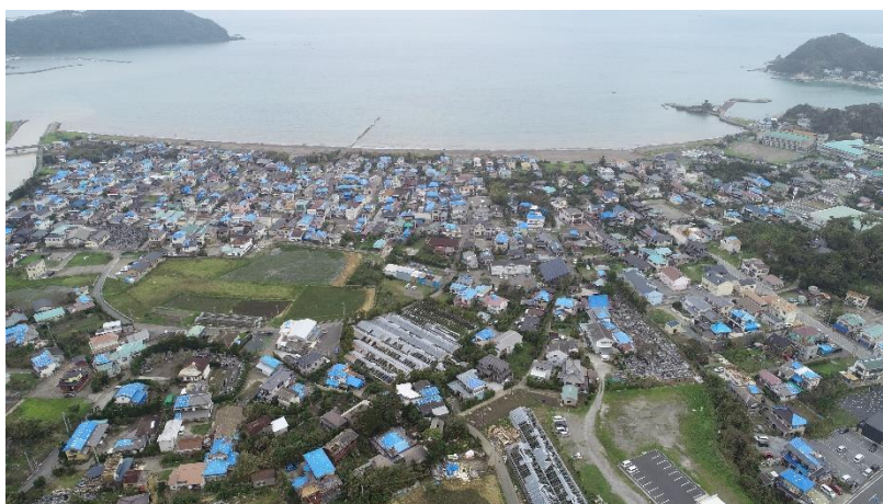
令和元年台風による被害
