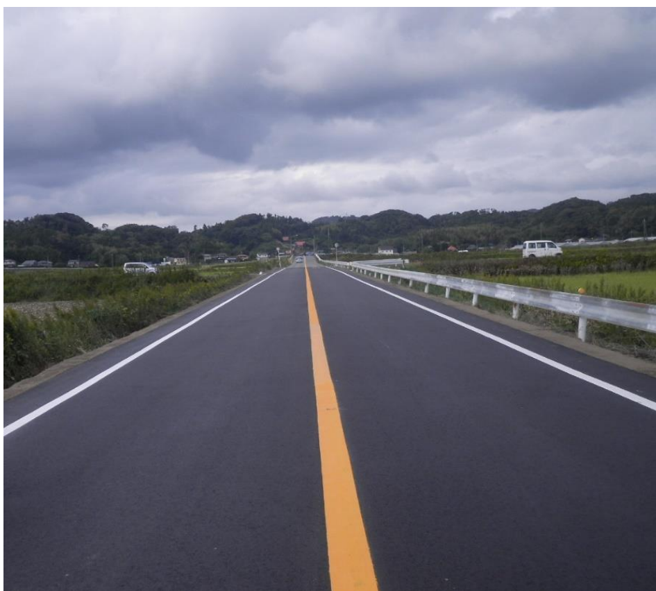
池之内9号線舗装修繕
