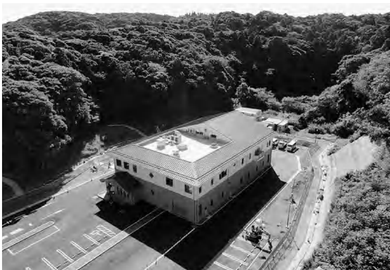
南房総市水処理センター
