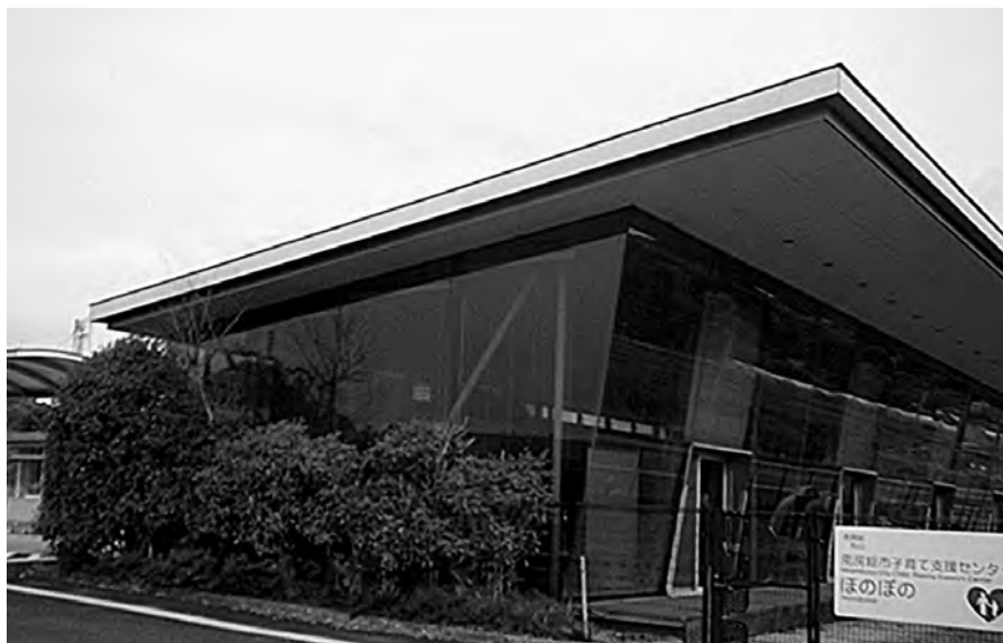
改修予定の南房総市子育て支援センター「ほのほの」
