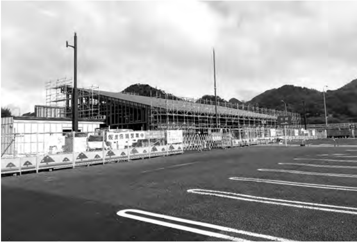
工事中の道の駅 富楽里とみやま
