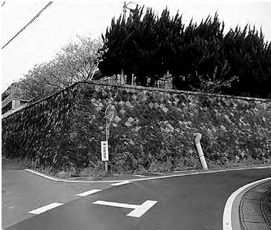
千倉中学校の石積擁壁
