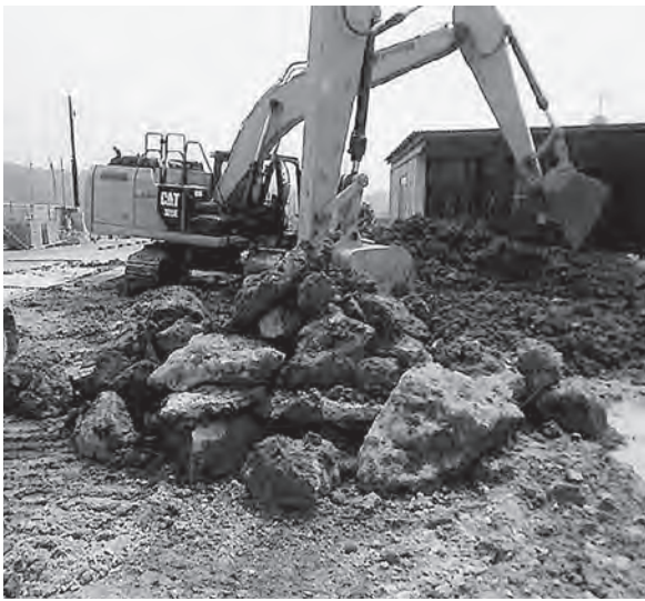
コンクリートガラ
