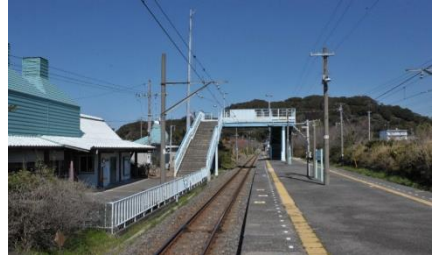
■富浦駅の跨線橋
