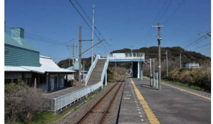
■富浦駅の跨線橋
