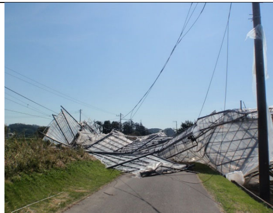
農業用ハウスの被害②
