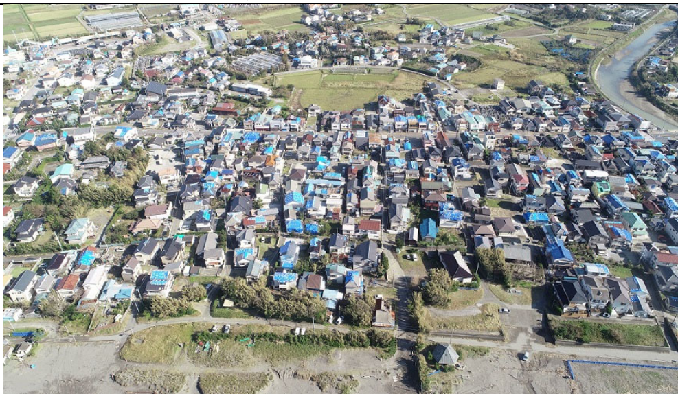
家屋の被害(富浦地区)
