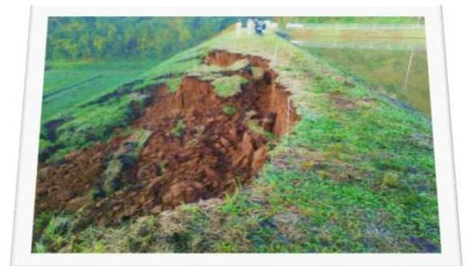
令和元年10月25日の大雨により、堤体の一部が崩落したため池。このような状態になると、必要な時に大切な水が使用できなくなる恐れがあります。
