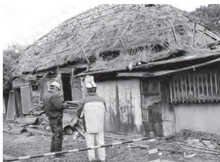
屋根材が飛散・落下した状態
