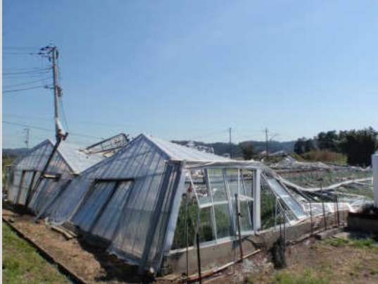
令和元年台風第15号による 農業用ハウス倒壊
