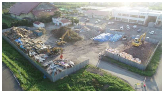
災害廃棄物仮置き場 (市役所本庁東側駐車場)
