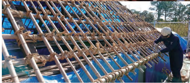
旧尾形家住宅修理状況
