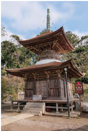
石堂寺多宝塔竣工状況
