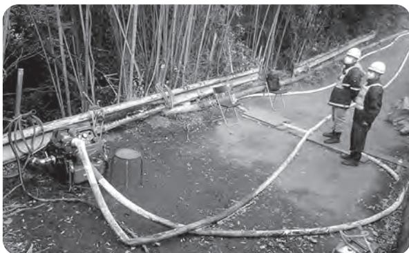
断水を回避するため、近くの河川からポンプによる水の汲み上げを行い、小向ダムへ補水をしています。
