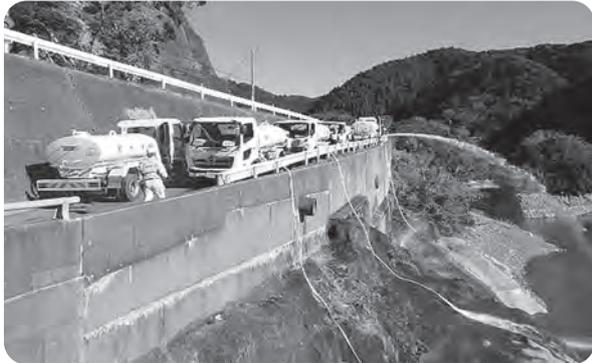
断水を回避するため、散水車により、他の水源から取水し、小向ダムへ補水をしています。
