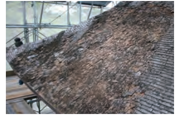
屋根の損壊状況
