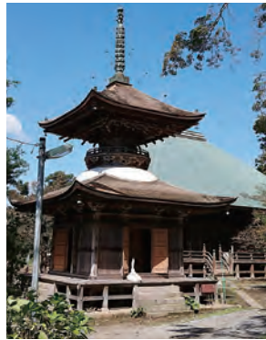
被災した石堂寺薬師堂
