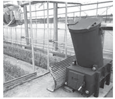
約130坪までのビニールハウスなどの加温が可能で、7~8時間程度燃焼します。
