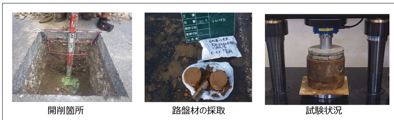
写真-2.6.2 開削調査の状況
