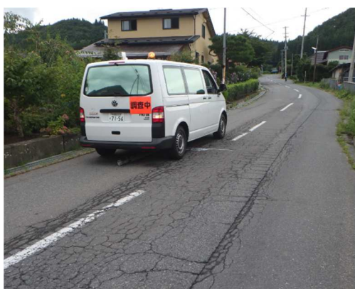
写真-2.6.1 FWD 調査状況
