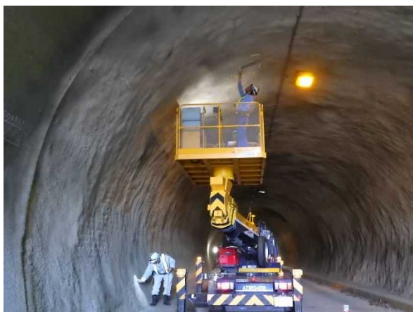
写真 3.1 トンネル点検車による点検状況
