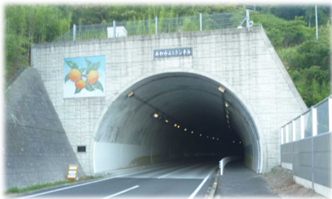
安房三芳トンネル
