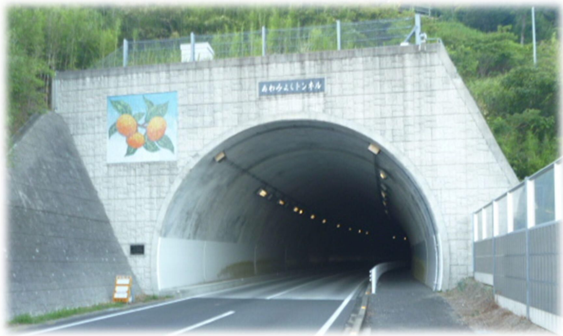
安房三芳トンネル
