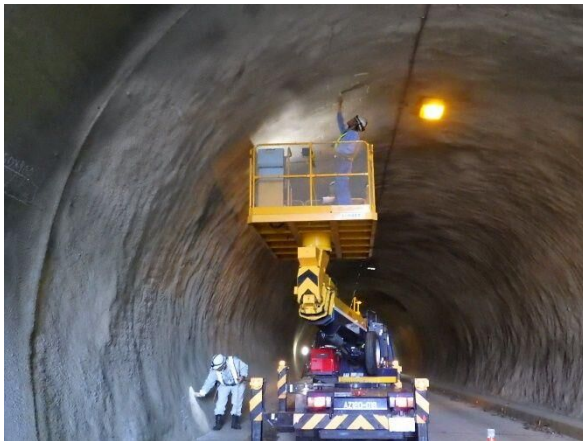
写真 3.1 トンネル点検車による点検状況
