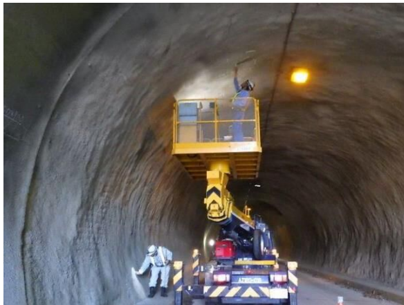
写真 3.1 トンネル点検車による点検状況
