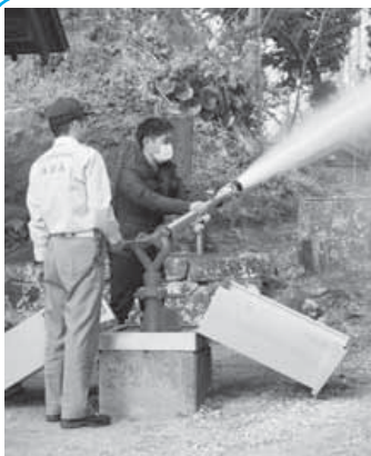
放水銃による放水訓練
