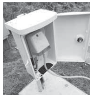
外部電源設備
