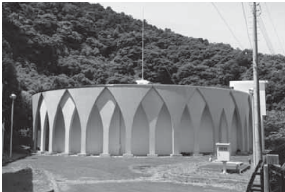
富山第6配水場(富山地区高崎)
