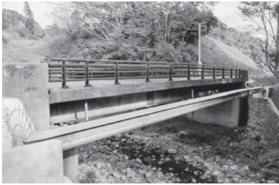
紅葉橋水管橋(富山地区山田)
