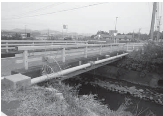
川内橋水管橋(丸山地区白子)
