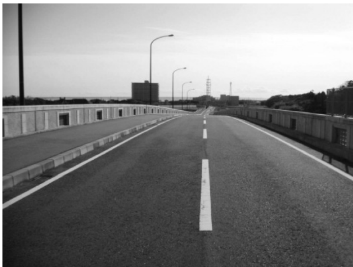
丸山７号線 海一望橋付近から
