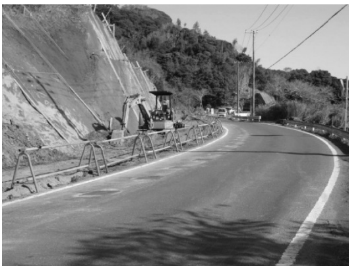
県道和田丸山館山線 改良工事状況
