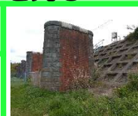
陸地部分の橋梁跡
