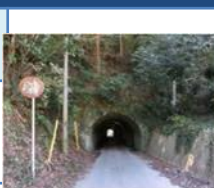
仲尾沢トンネル
