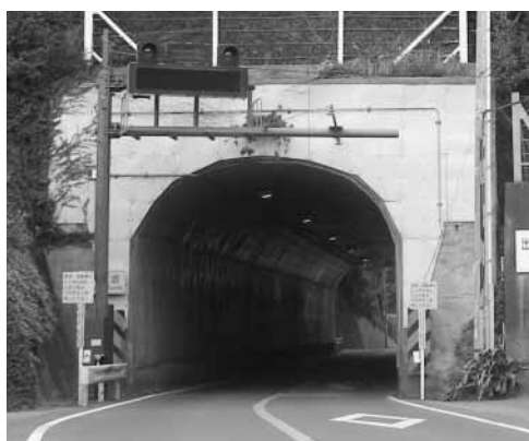
坂下トンネル(現状) (幅員片側2.75メートル、歩道なし)
