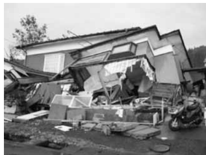
新潟県中越沖地震での被害状況
